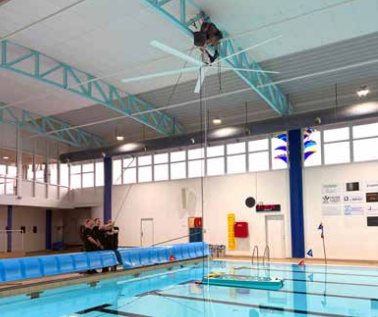
Februar 2023, hvor 2 store HVLS-ventilatorer fra Nordicco A/S installeres af et klatre-hold.
