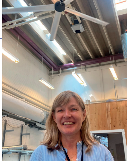
Oppe under loftet på en forsøgshal på Teknologisk Institut drejer fem vinger langsomt og lydløst rundt over hovedet på projektleder Merete Lyngbye. Nydesignede vinger skaber luftcirkulation og et mere behageligt indeklima.
